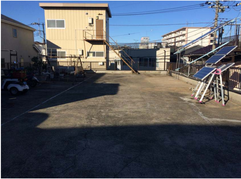
川崎市テナントビル駐車場防水工事
