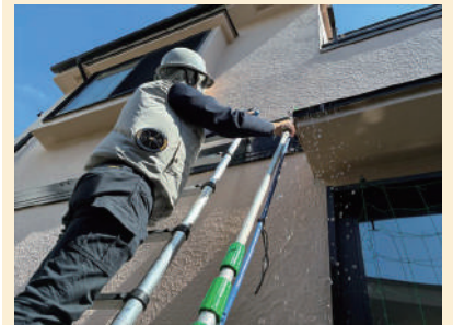
空調服を着用しての作業風景。日本外装のスタッフも空調服ユーザーが増えました。
