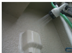
散水調査風景。シャワーヘッドで散水。エアコンの管が壁を貫通し、室内から室外機へ伸びています。このような箇所は雨水の浸入箇所である可能性があります。
